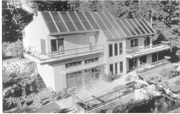
Şekil 1- Fotovoltaiklerin bir konut çatısında uygulanması – Boston-A.B.D. [1]
