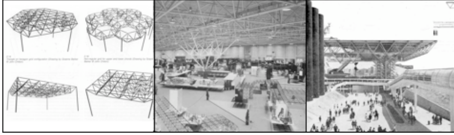
Şekil 1- Düz-yüzeysel uzay kafes sistem modülleri ve uygulama örnekleri [3,4,5].
