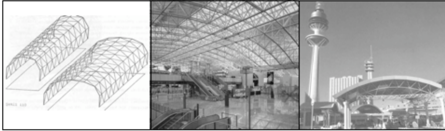
Şekil 2- Tonozsalsal uzay kafes sistem modülleri ve uygulama örnekleri [1,4,6].
