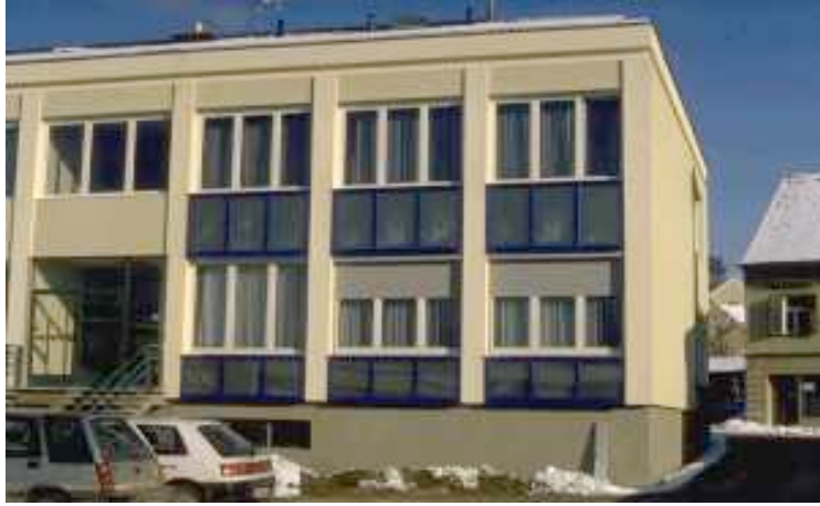
Şekil 3.3- Saydam yalıtım malzemesi uygulanan büro binası cephesi [13]
