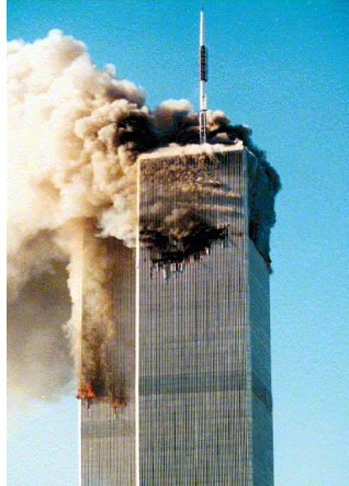
Resim 3- Dünya Ticaret Merkezi Yangını (11 Eylül 2001), uçak çarpmasıyla çıkan yangın sonucunda yıkılan yapının taşıyıcı sistemi püskürtme sıvalarla korunmaktaydı[11]
